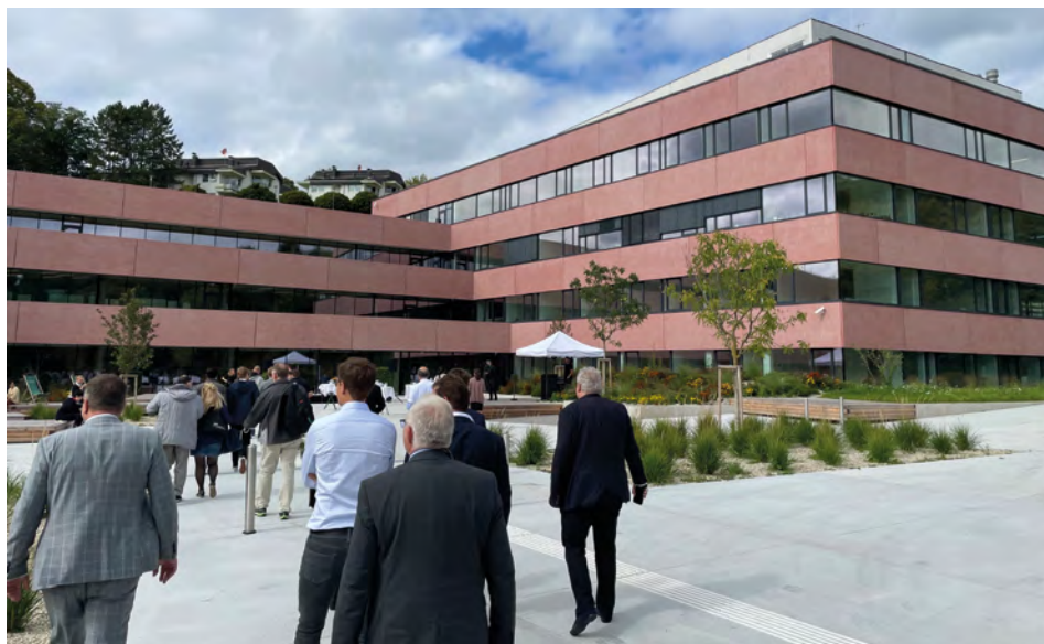
Das neue Gebäude der ISTA „Lab 5“
