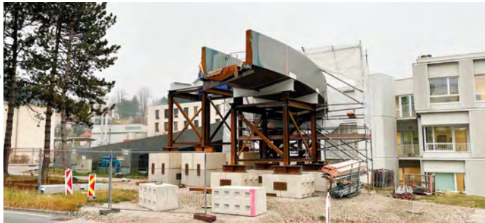
Die Fußgängerbrücke befindet sich derzeit noch im Bau
